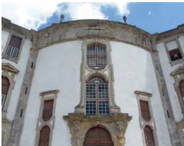
Corpo central da fachada
